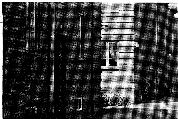
Kvarteret Akacian vid Spånehusvägen
